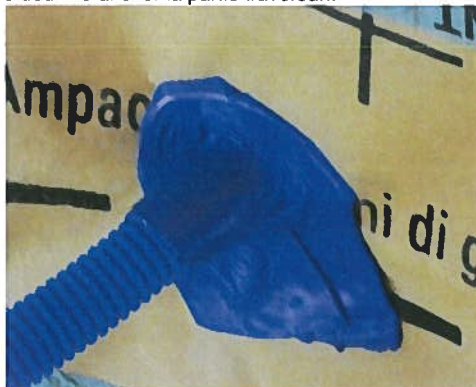
Etape deux : étancher la partie traversant
